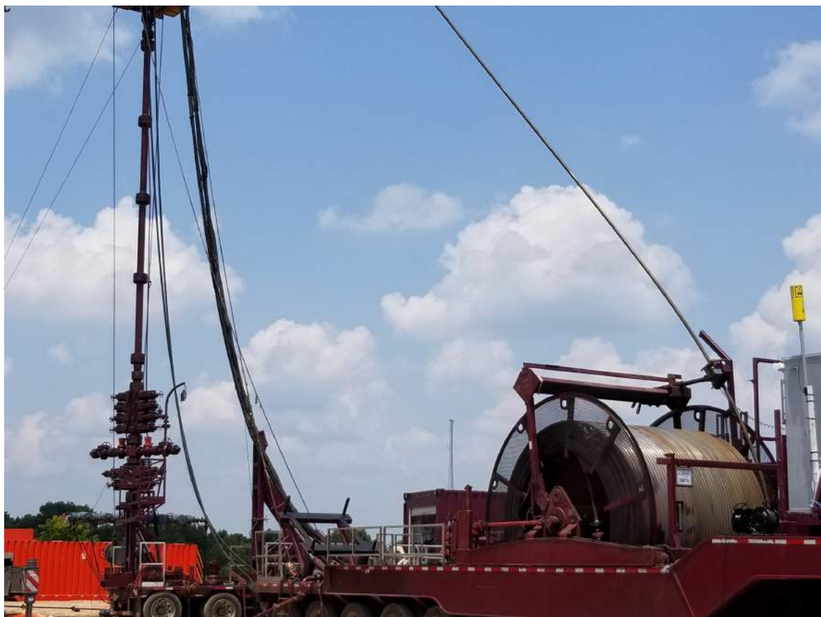
Abbildung 3: Einsatz der Coil-Tubing-Anlage im Bohrloch am Standort Jewell in Carter County, Oklahoma
