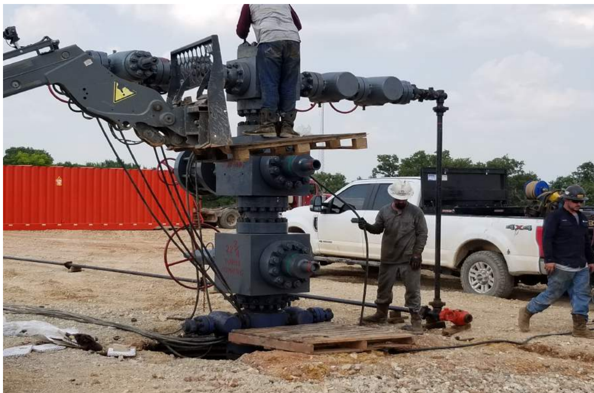
Abbildung 1: Installation des Produktionskreuzes (Christmas tree) auf Bohrloch Jewell, Carter County, Oklahoma.
